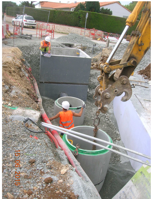
Figure 8 : pose d'un réseau eaux pluviales
