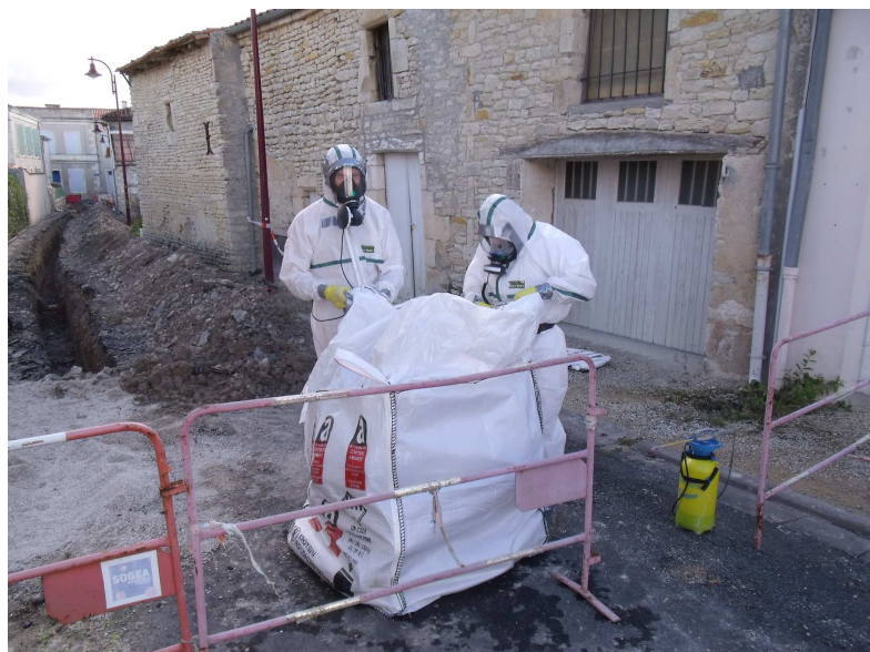
Figure 9 : procédure de désamiantage en cours
