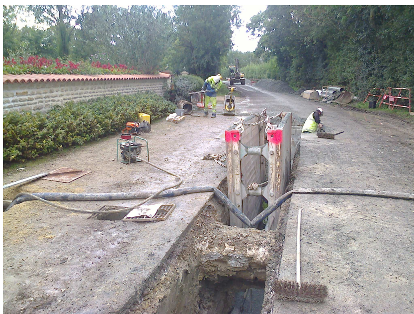
Figure 6 : pose d'un réseau EU avec blindage
