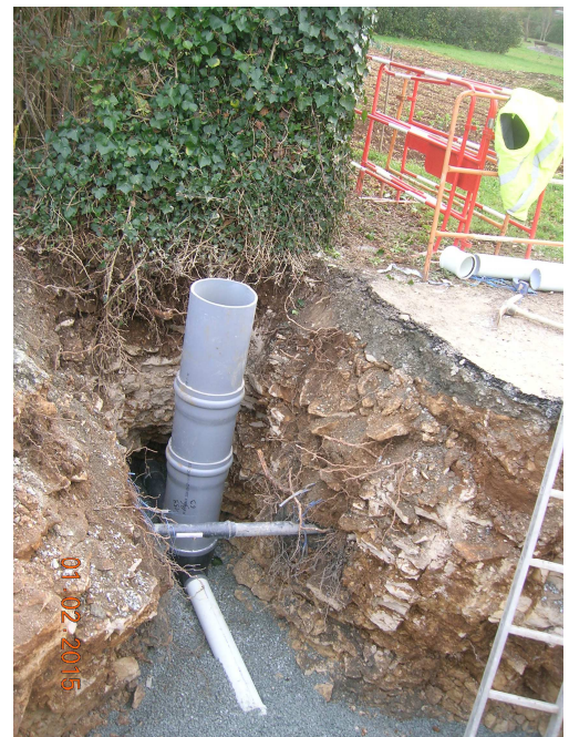
Figure 4 : réalisation d'un branchement
