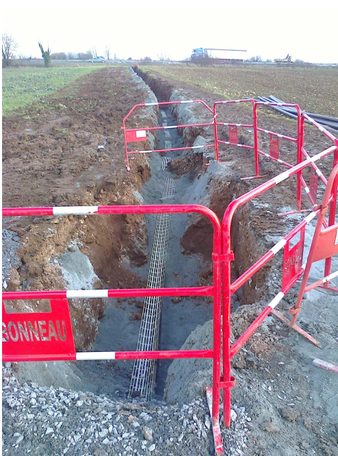
Figure 5 : pose du refoulement entre Moulin-Neuf et Echiré
