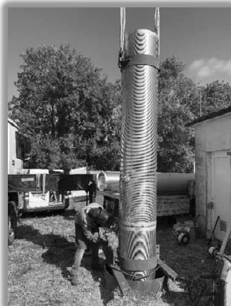
Réhabilitation du forage de Grand Bois Battu à Vernoux-sur-Boutonne
