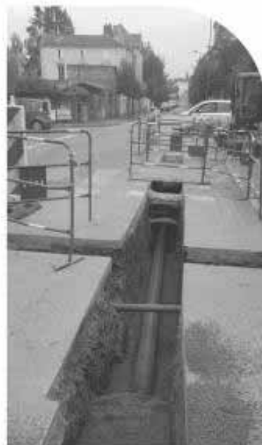
Travaux de renouvellement de canalisation d'eau potable
