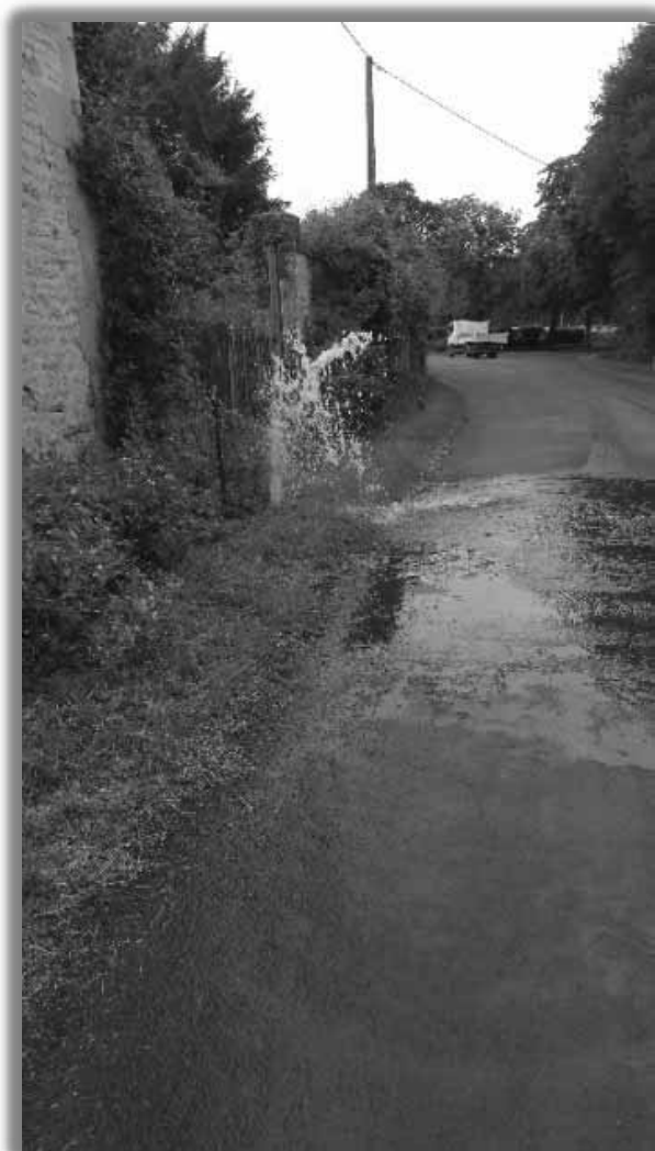
Réalisation d'une purge sur le réseau
