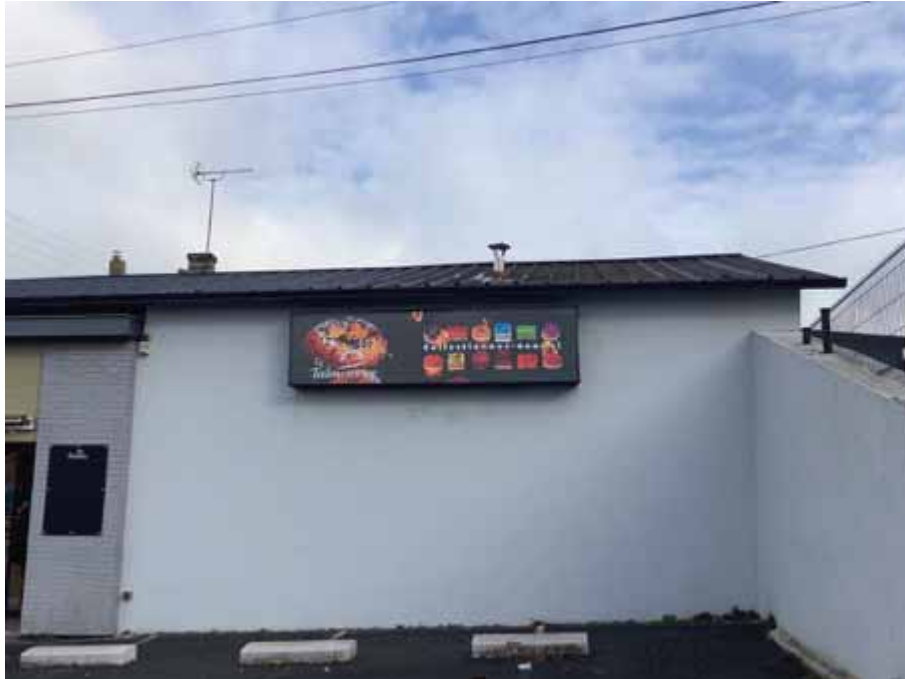
Enseigne numérique parallèle au mur en ZP1, Niort, Janvier 2022
